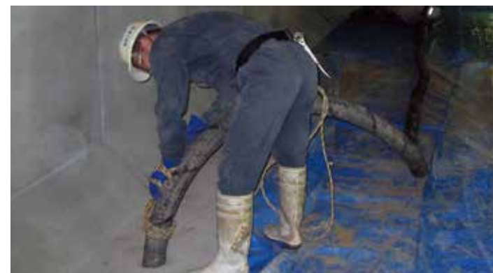
底版モルタル充填工例
