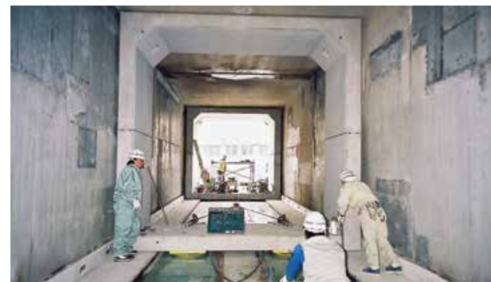
狭隘部分の施工例【w=15.8t】
