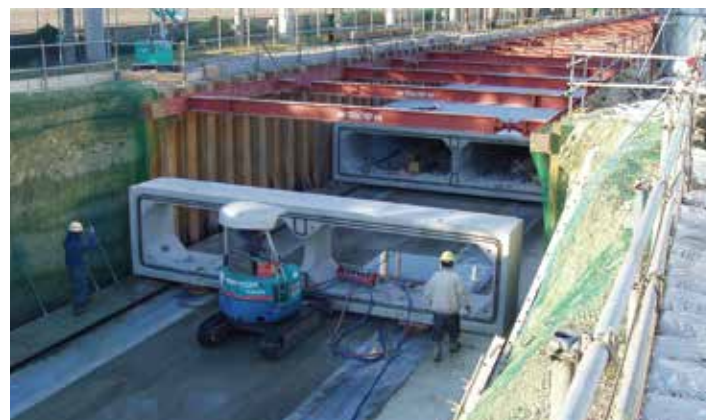
長距離施工例（移動距離 206m）【w=12.3t】
