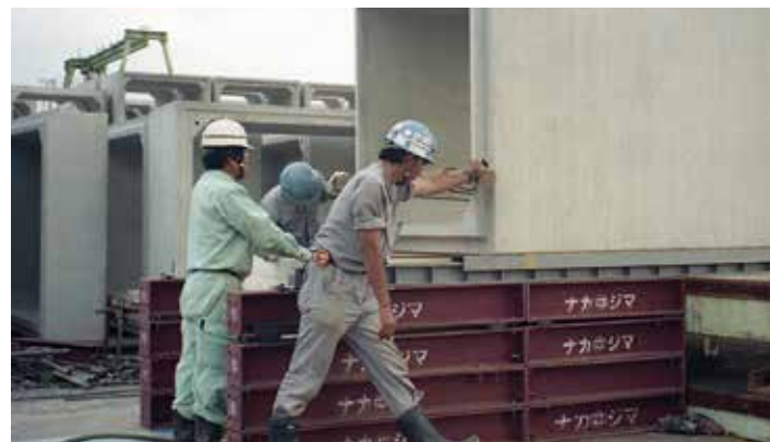
落差施工例（下流側より上流側への移動：落差 1.0m）
