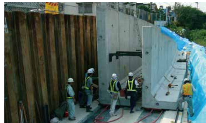
L型部材の連結施工例【w=11.6t】
