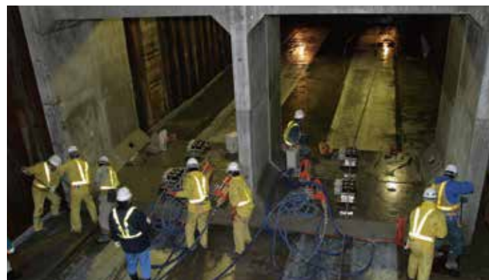
連結施工例（2 函体連結）【w=67.4t】
