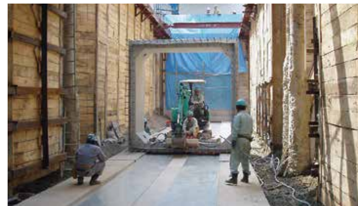
V字勾配区間の施工例（縦断折れ角 1°06' 05"）【w=12.2t】
