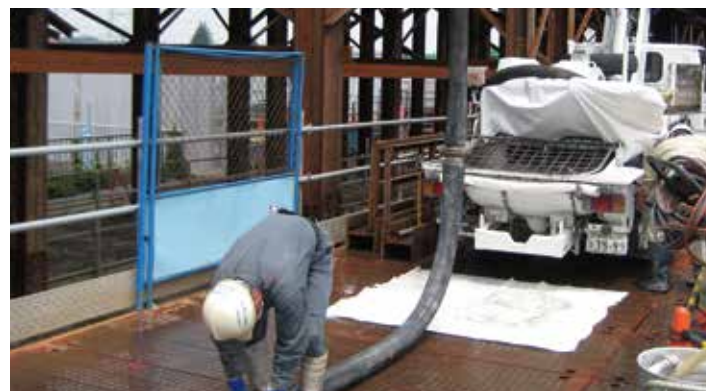
コンクリートポンプ車配管状況例
